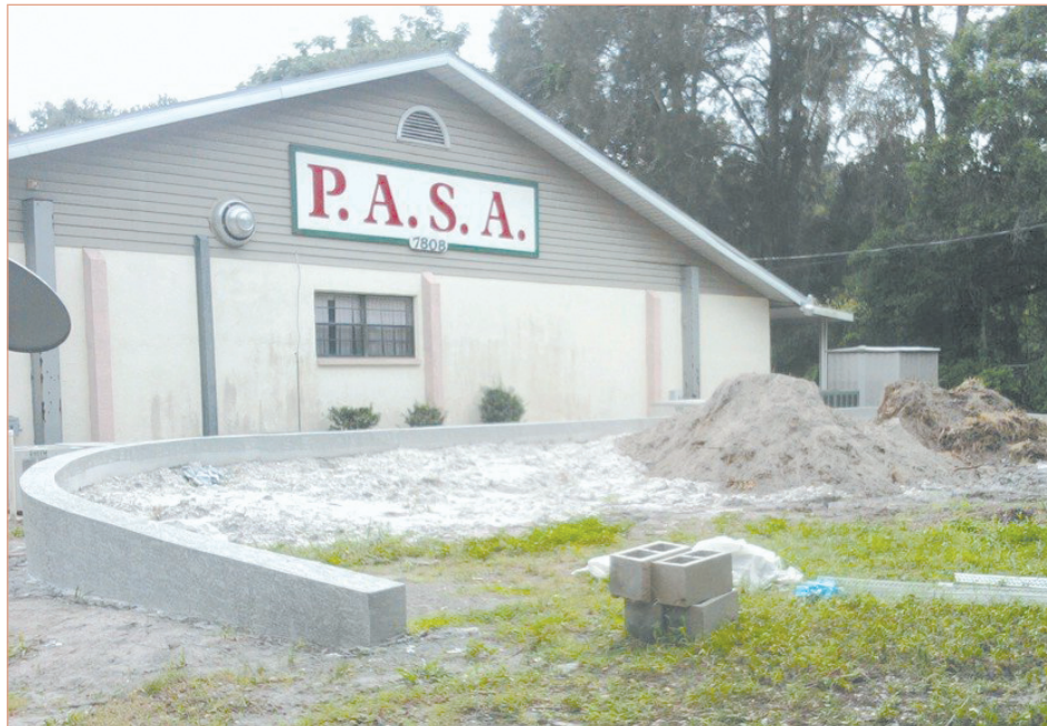
▼ Um aspecto das obras exteriores que estão a decorrer na sede da PASA, em St. Petersburg, FL
